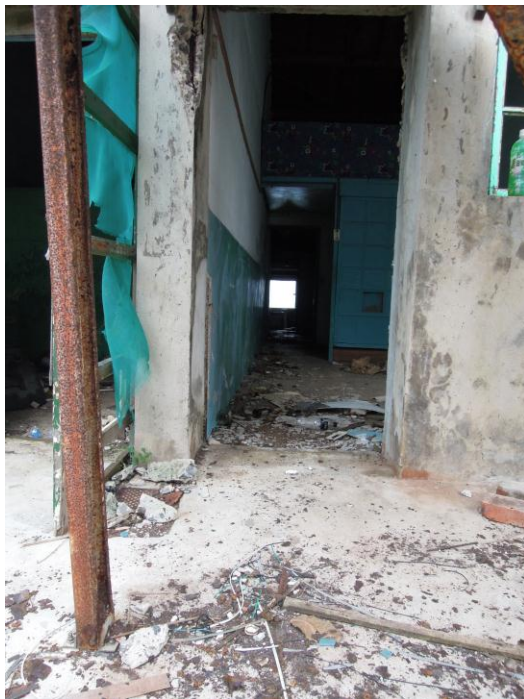
圖為莒光新村居民搬遷後現況
