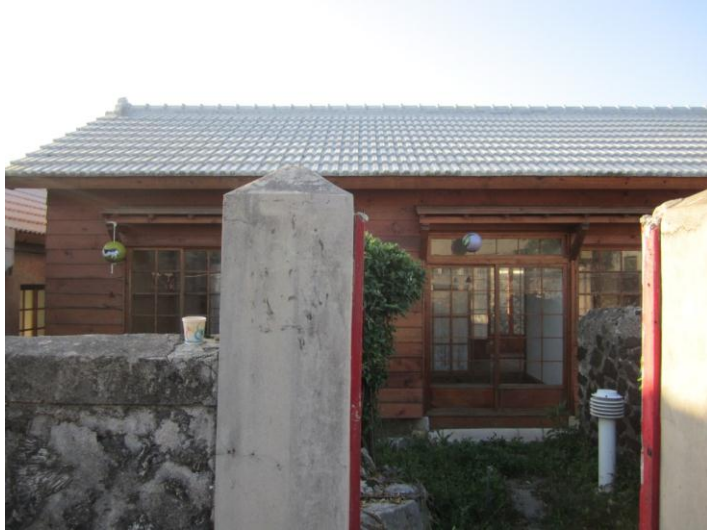
圖為保存區裡被翻修的日式建築
